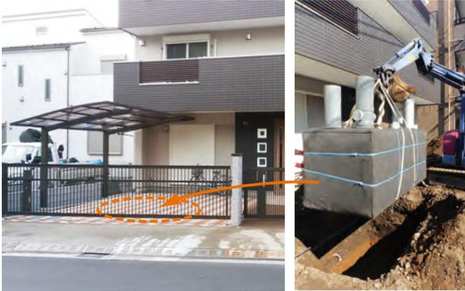
樋で十分ろ過した雨水を、駐車場下の2tタンクに蓄雨しています。
