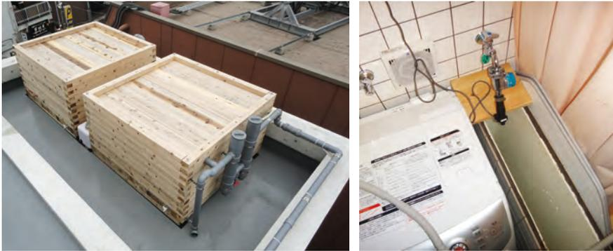
屋上に設置した木製の雨水タンクに、上階の屋上から雨水を引いて、タンク脇の装置でろ過して蓄雨しています。
